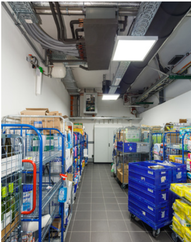
Das Kältemittel fließt beim HVRF-System nur zwischen dem Außengerät und der Verteilereinheit (oben im Bild). Hier wird Energie vom Kältemittel auf Wasser übertragen, das dann zu den Innengeräten weitergeleitet wird.
