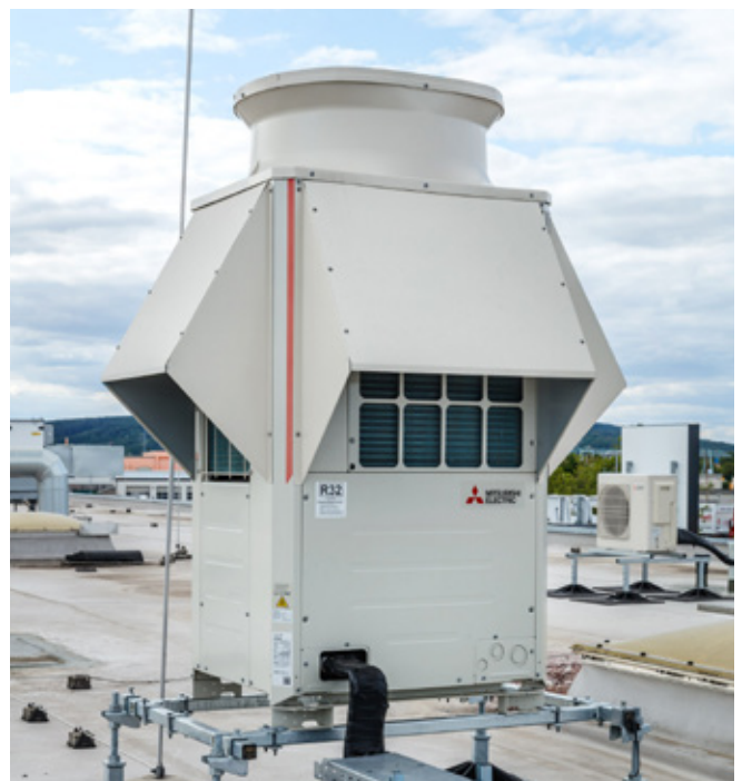
Neben einem geringeren GWP weist R32 eine rund 20 % höhere volumetrische Kälteleistung gegenüber R410A sowie einen etwa 4,4 % höheren theoretischen COP auf.
