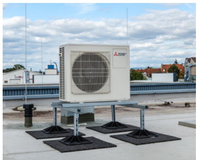
Das Außengerät aus der M-Serie hat eine Kälteleistung von 7,2 kW und versorgt drei Innengeräte in den Personalräumen.
